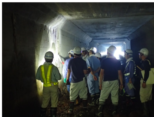
コンクリート橋点検
