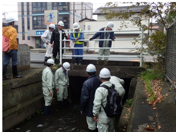
コンクリート橋点検
