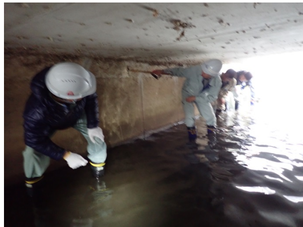
コンクリート橋点検
