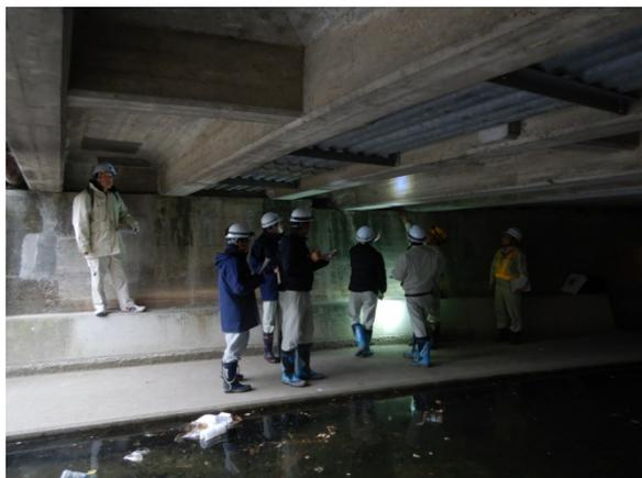
桁下部の状態を近接目視点検
