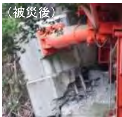
制震ダンパー取付部の損傷
