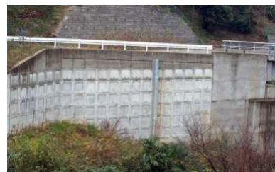
盛土（補強土壁）
