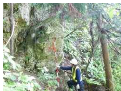
(危険度調査状況)
