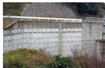
盛土(補強土壁)
