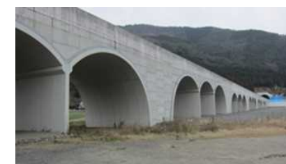
アーチカルバート
