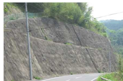
モルタル吹付
