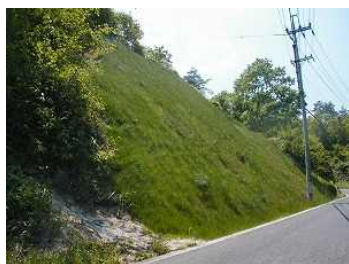
切土(法面保護)
