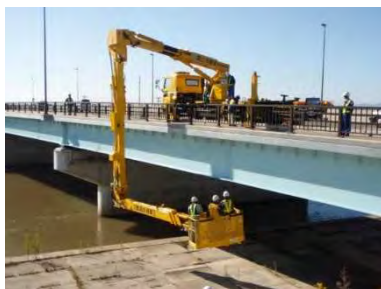
橋梁点検車による点検
