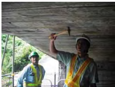
目視及びハンマーによる打音検査
