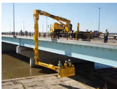
橋梁点検車による点検
