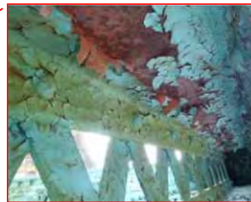
鋼材の腐食
