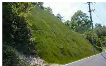
切土（のり面保護）
