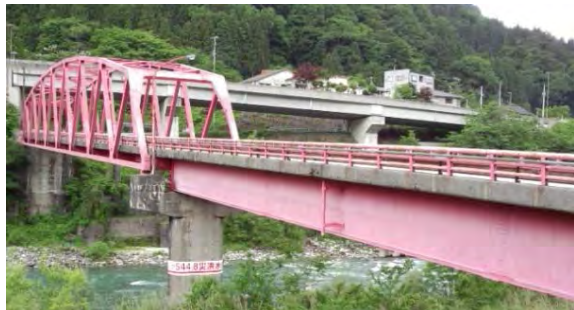
〈音沢橋の状況〉
