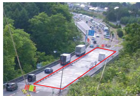
橋梁床版修繕工事の実施に伴う渋滞発生状況
