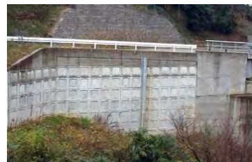
盛土(補強土壁)
