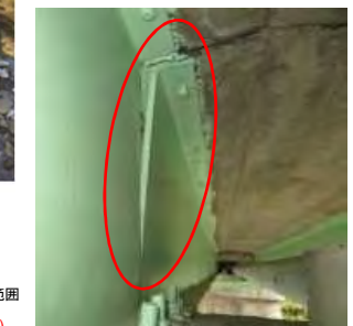
主桁の変形
