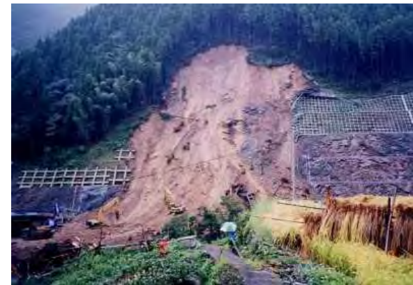
強風化・土砂化斜面での崩壊例
