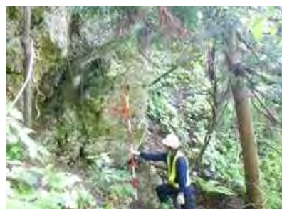
(危険度調査状況)
