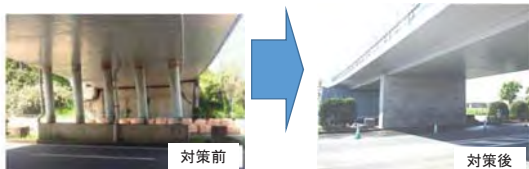
耐震補強の施工例
