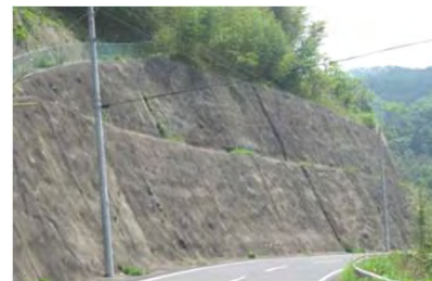
モルタル吹付
