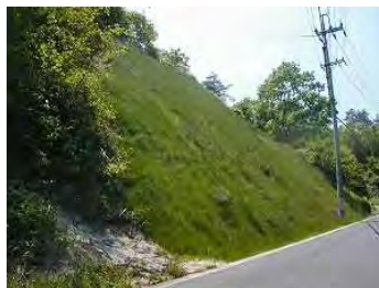
切土(法面保護)
