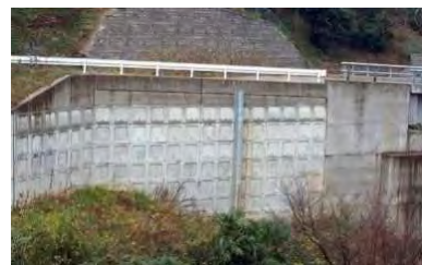
盛土（補強土壁）
