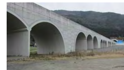
アーチカルバート
