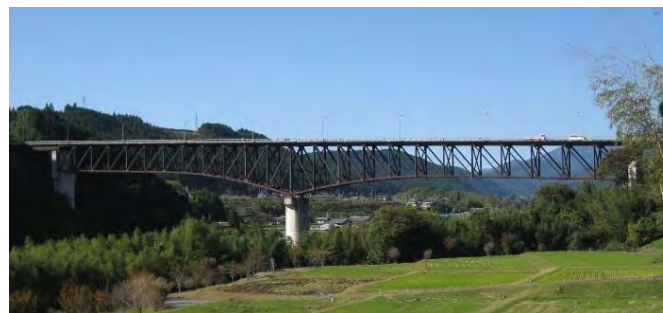
〈乙姫大橋の状況〉
