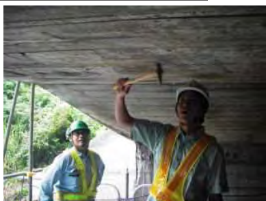
目視及びハンマーによる打音検査
