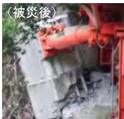
制震ダンパー取付部の損傷
