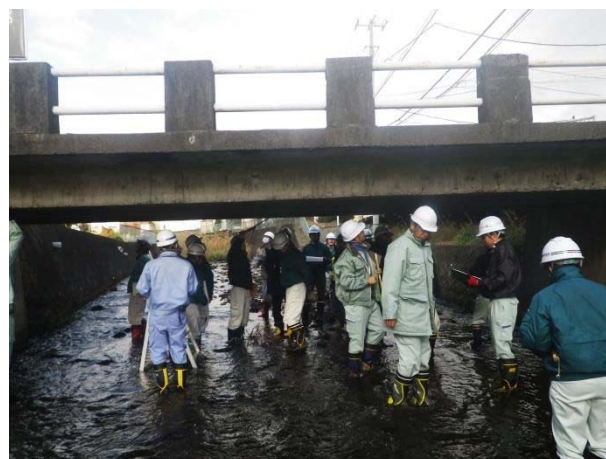
コンクリート橋点検
