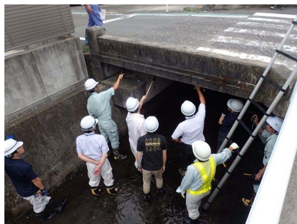
コンクリート橋点検
