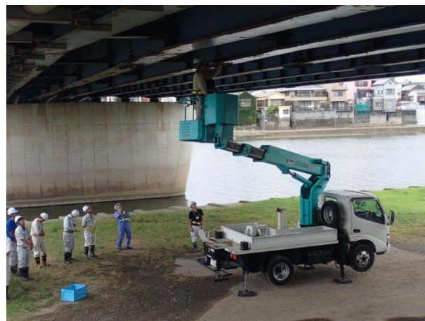
鋼橋点検(高所作業車による近接目視点検)
