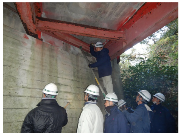
支承部の状態を近接目視点検
