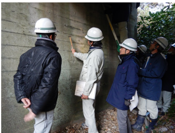
下部工の状態を打音点検
