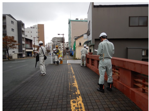
橋面の状態を近接目視点検
