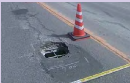
ひょうめん 表面(コンクリート)の一部が抜け落ち、 あ 空いた穴
