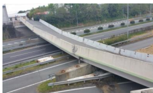
写真-1 県道小川嘉島線 府領第一橋
