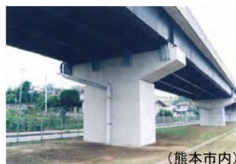
写真-3 国道3号 跨線部 (熊本市内)
