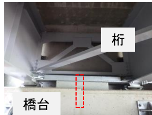
写真-5 アンカーバーのイメージ
