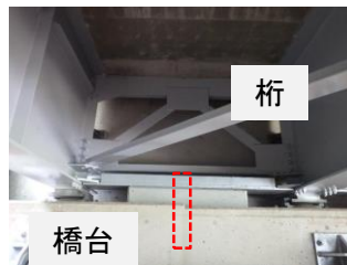
写真-5 アンカーバーのイメージ
