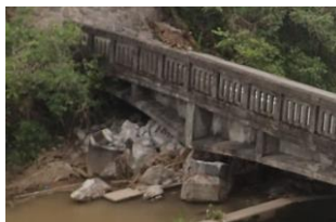
写真-2 平田・小柳線 田中橋
