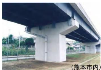
写真-3 国道3号 跨線部 (熊本市内)
