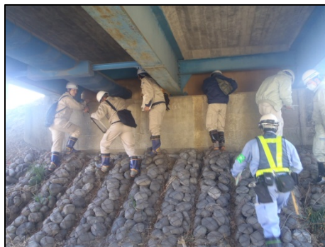
鋼橋端部の点検の様子
