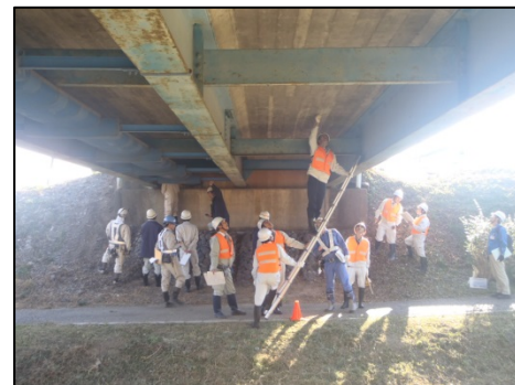
梯子を使用しての点検状況(床版)
