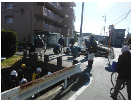
RC橋およびPC橋を近接目視や打音検査の実習しました
