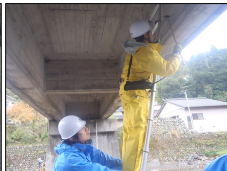
梯子を使用しての点検状況(梁部)
