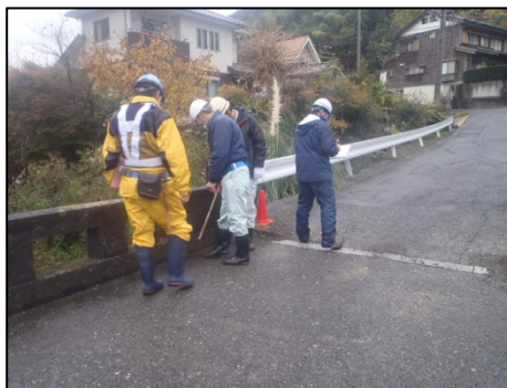
橋面の点検状況
