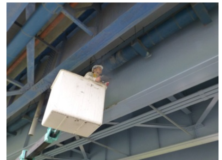
高所作業車による近接目視
