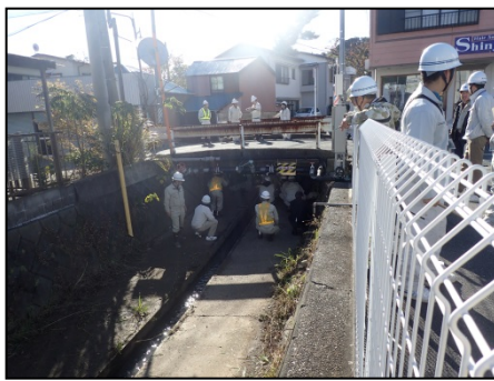
コンクリート橋を点検しました
