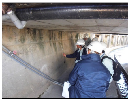
打音検査を実習しました
