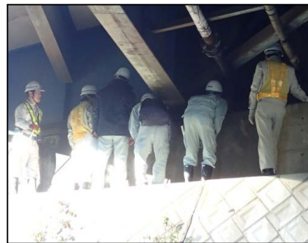
鋼橋を点検しました
