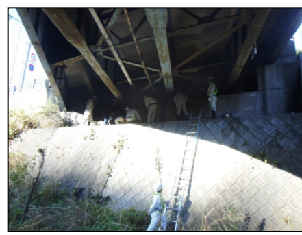
梯子を使い点検を行ないました
