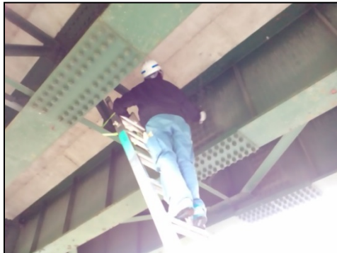
梯子を使い点検を行ないました
