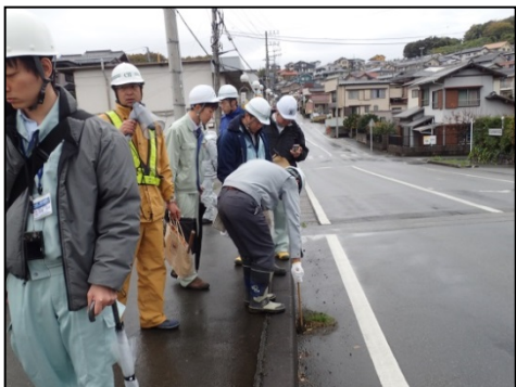
橋面(集水ます)の点検状況
