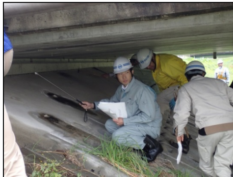
コンクリート橋を点検しました
