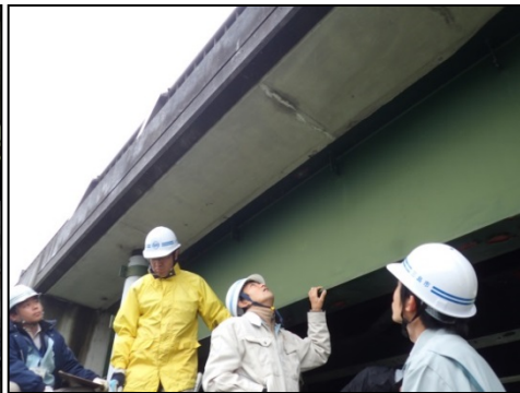
鋼橋を点検しました
