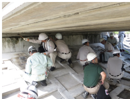
支承部及びその周辺の腐食・損傷等の異常の確認
