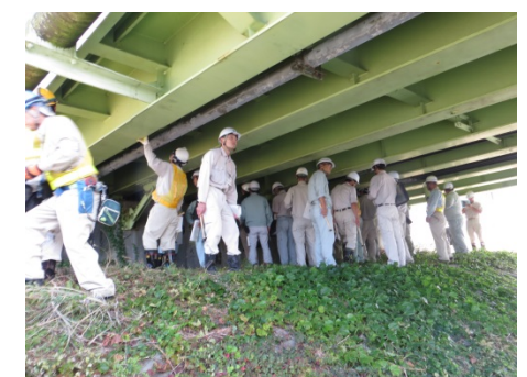
支承部及びその周辺の腐食・損傷等の異常の確認
