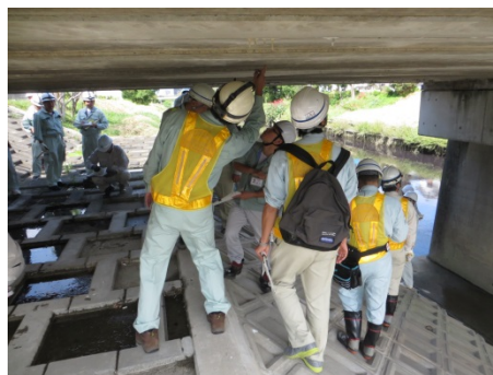
PC橋の近接目視及び打音検査の実習をしました
