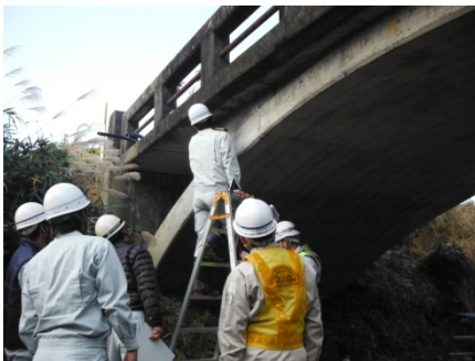
RCアーチ橋を近接目視や打音検査の実習しました
