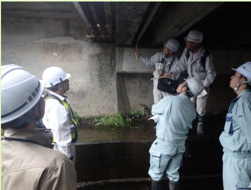
ハンマーでたたきながら橋の下面を点検
