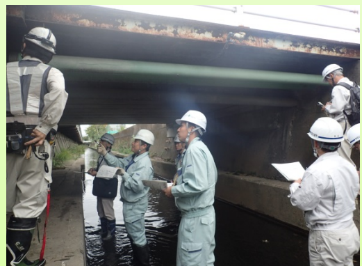
橋の下面を点検し見つけた損傷を図化
