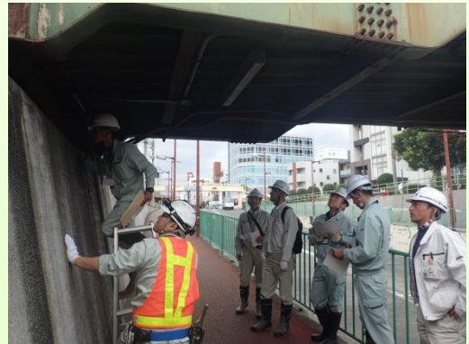
はしごを使った歩道橋の近接目視点検
