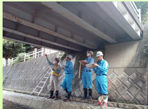
橋の下面を点検し損傷を図化
