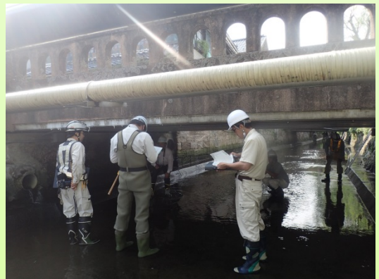
現地点検（橋の下面を点検）
