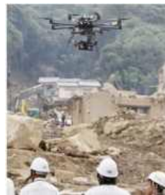
ドローンによる調査状況
