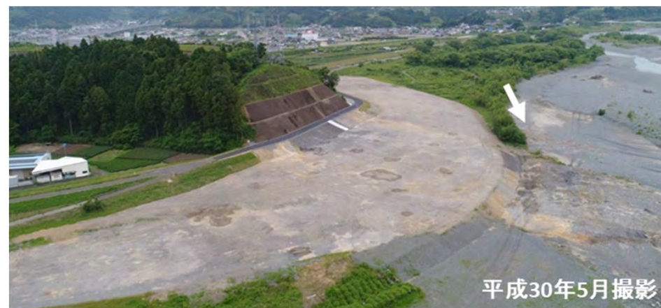
写真 牛尾山開削後(右岸19.4～19.6k付近)
