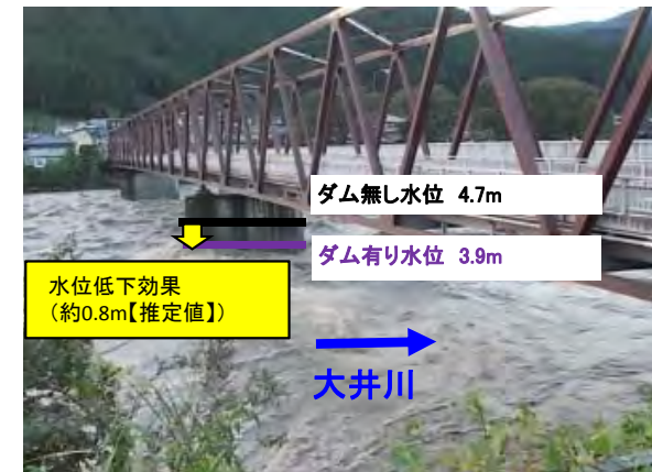
写真 川根大橋地点の状況
