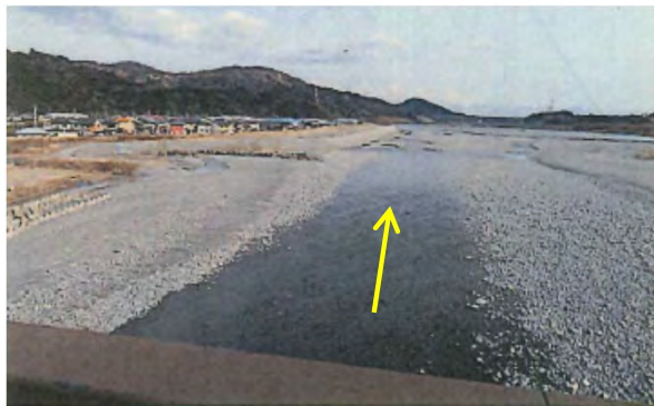
写真 水路橋(21.0km付近)下流 平成30年2月22日
