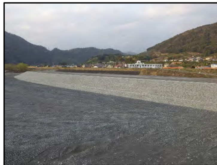
写真 高水護岸整備後 (大井川左岸22.2k付近上神座地区)
