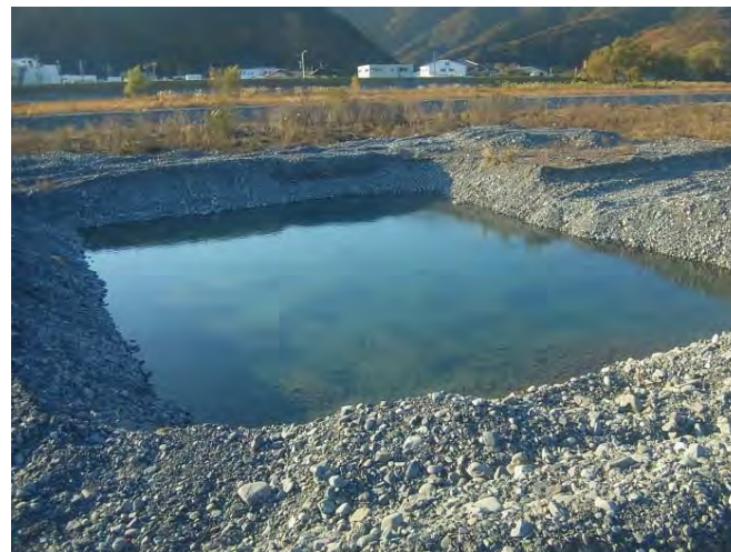
有識者の助言を踏まえた濁水対策(沈砂池の設置)
