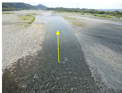
写真 水路橋(21.0km付近)下流 平成25年8月18日
