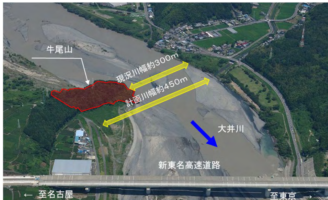
図 整備箇所(19.4k～19.6k付近)
