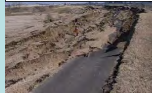
鳴瀬川水系鳴瀬川(左岸30.0km)
