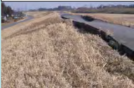
北上川水系江合川(左岸21.6km)
