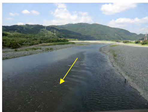
写真 水路橋(21.0km付近)上流 平成25年8月18日
