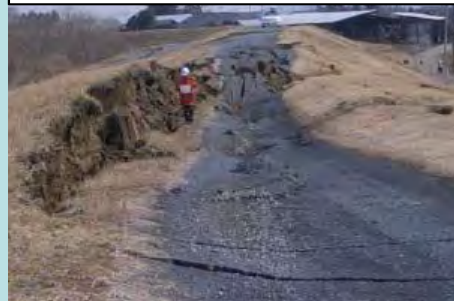
鳴瀬川水系鳴瀬川(左岸12.0km)
