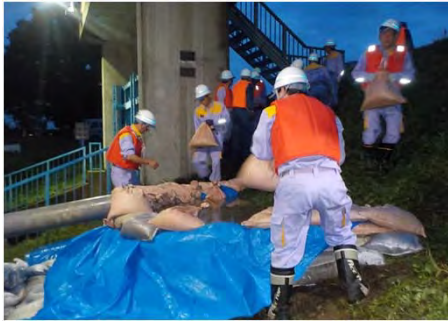
岐阜市水防団 漏水対策
