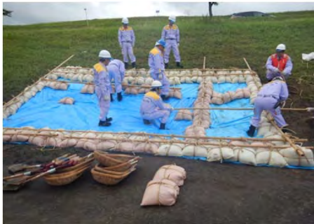
岐阜市水防団 堤防法崩れ対策
