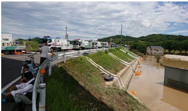
排水作業を行う排水ポンプ車 (岡山県倉敷市)
