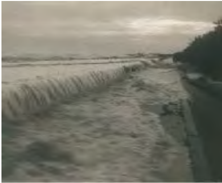
海岸堤防の越波状況
