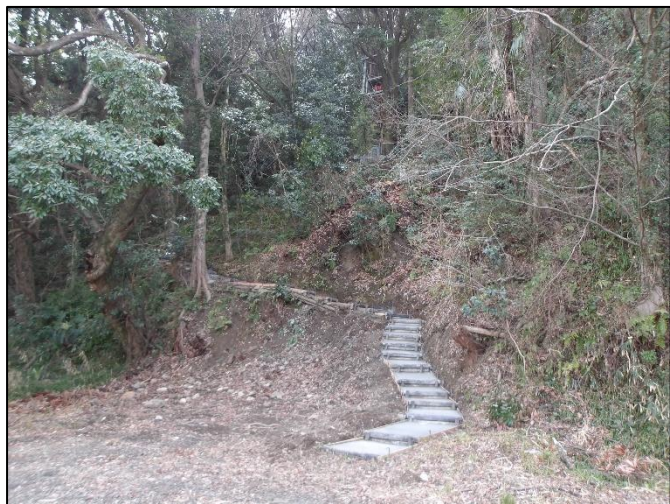
スロープ(コンクリート舗装)施工中
