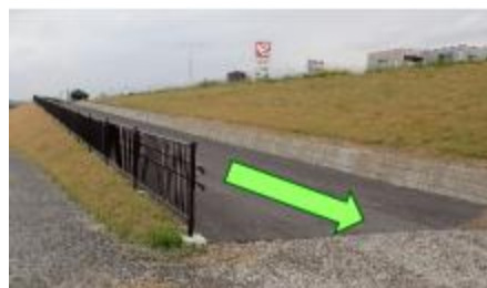
高水敷への緩やかな坂路
