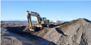
河道掘削工事 大井川0.6k付近
