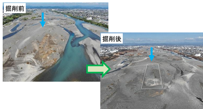
令和6年度 大井川下流部河道掘削工事 河道掘削(飯淵・中島地区)大井川 0.6k付近
