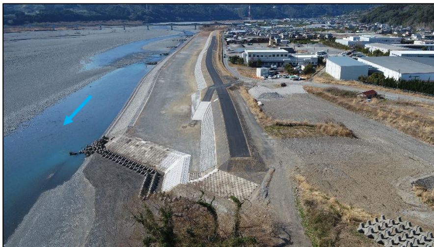
写真 堤防整備後 (大井川左岸20.0k付近神座地区)
