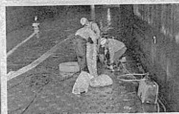
排水作業完了後は、吉田町からの要請を受け、停電が発生した特別養護老人ホーム（住吉杉の子園）（吉田町住吉323
