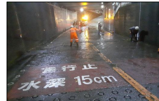
排水作業終了状況
