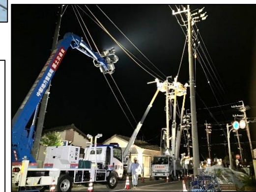
照明車を牧之原市での中部電力の夜間復旧作業にも使用しました。
