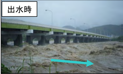
平成23年9月台風12号出水 谷口橋(10km付近右岸下流)
