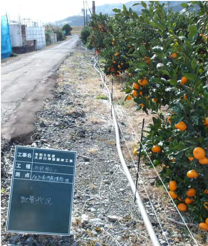
仮設上水道設置
