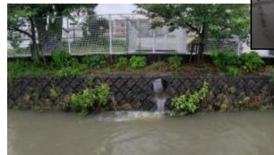
雨水貯留施設の整備(焼津市)
