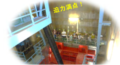
ダム内部見学(コンジットゲート)
