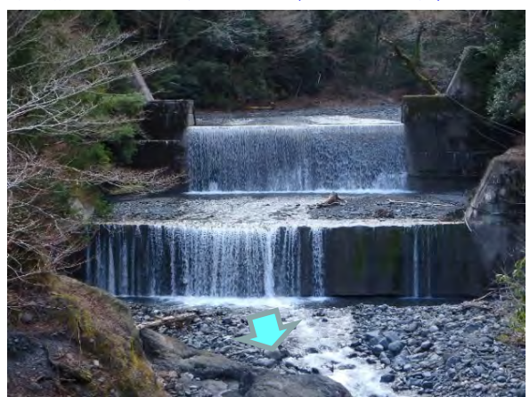
流木捕捉工設置前 (H27撮影)
