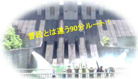
ダム内部見学(しぶき橋)
