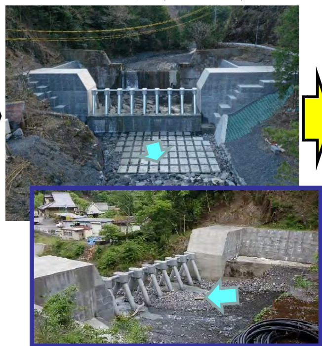
流木捕捉工設置後 (H30撮影)
