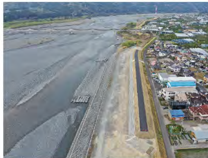
写真 高水護岸整備後 (大井川左岸20.6k付近神座河地区 下流より)
