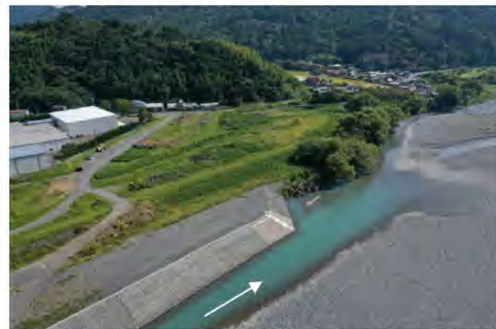
低水護岸整備(神座地区)大井川 20k付近 左岸
