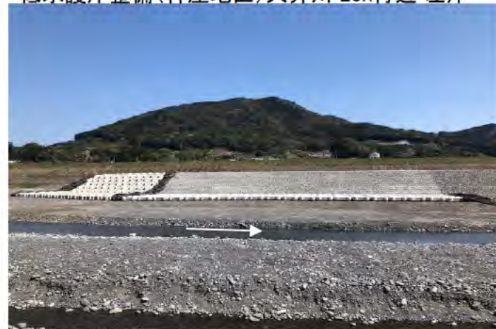
低水護岸整備(神座地区)大井川 22k付近 左岸
