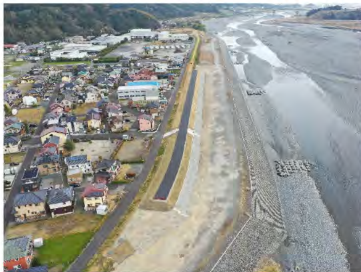
写真 高水護岸整備後 (大井川左岸20.6k付近神座地区 上流より)
