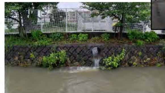
雨水貯留施設の整備(焼津市)
