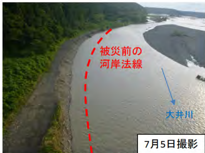
工事中道路兼管理用通路 一部洗掘
