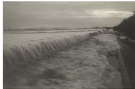
海岸堤防の越波状況
