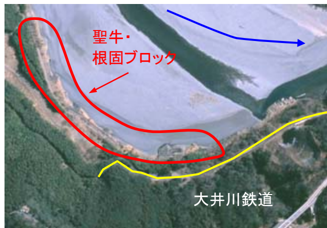
23.0km付近の状況
