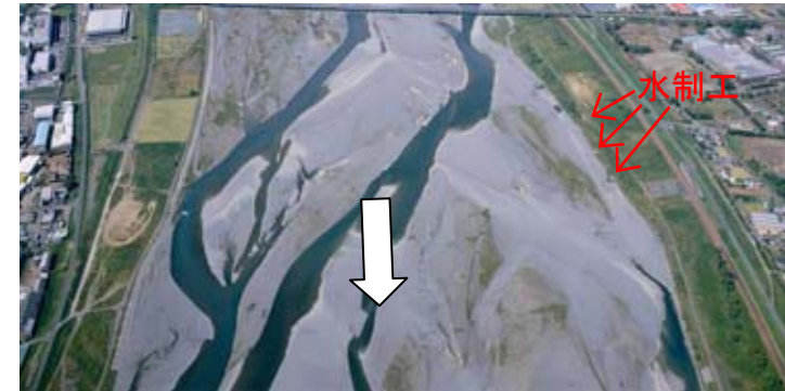
水制工(7.2km付近)の状況
