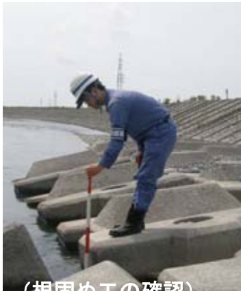
(根固め工の確認)
