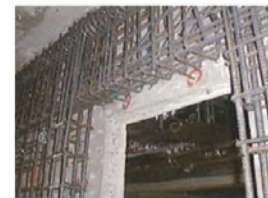
処理場の耐震化(躯体補強)
