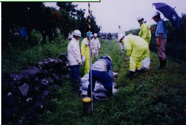
水防団の漏水対応状況
