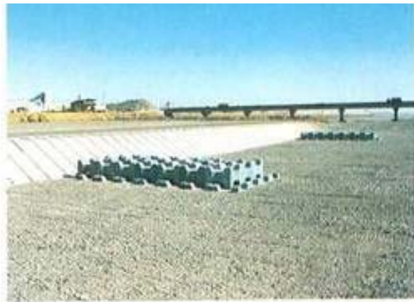
水制による河岸の保護(左岸5.0k)
