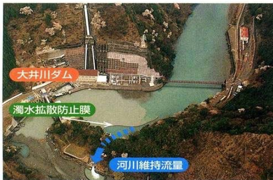
大井川ダムの濁水拡散防止膜の設置
