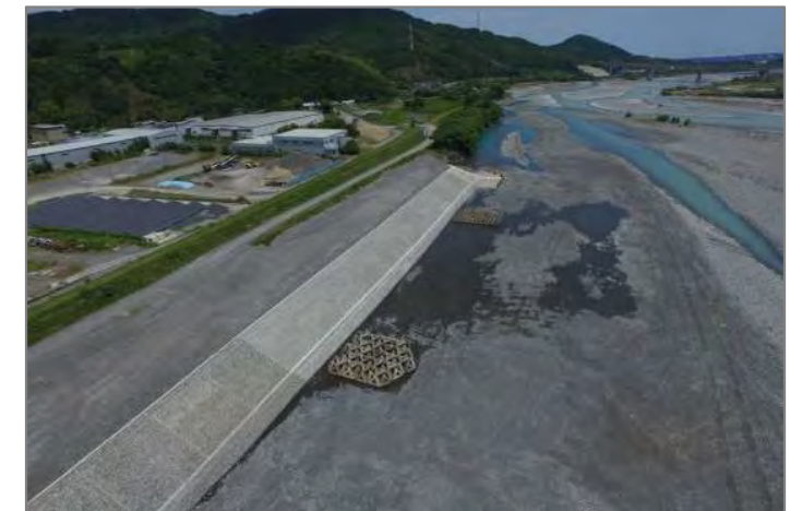
低水護岸整備(神座地区)大井川 20k付近 左岸
