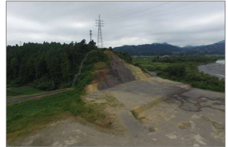
河道拡幅(牛尾地区)大井川 19.4k 右岸
