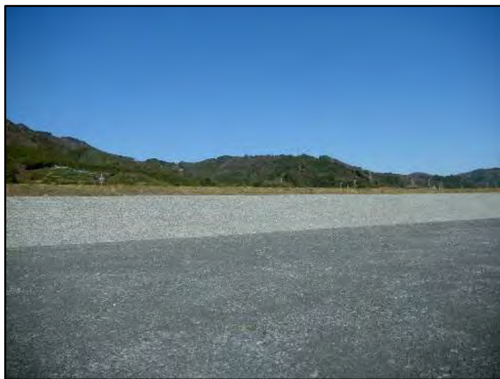
写真 低水護岸整備後 (大井川左岸22.0k付近上神座地区)
