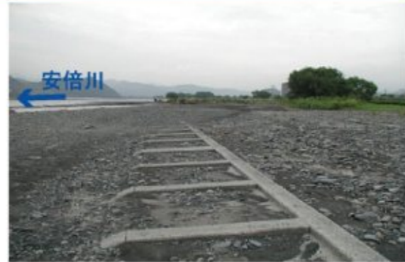
安倍川左岸6.0k付近
