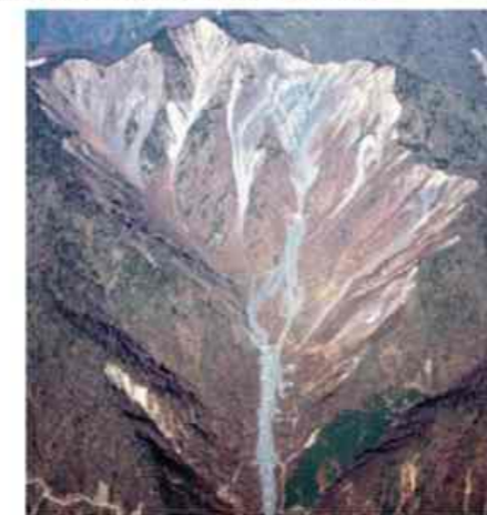
大谷崩れ(H17.11)
