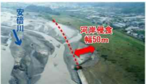
平成12年9月洪水(左岸11.75k付近)
