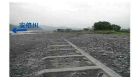
土砂の堆積により河床の高さが上昇しています。(安倍川左岸6.0km付近)
