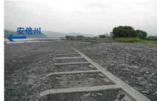
安倍川左岸6.0k付近
