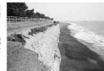
清水海岸の被災状況
