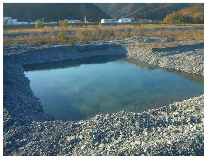
有識者の助言を踏まえた濁水対策(沈砂池の設置)
