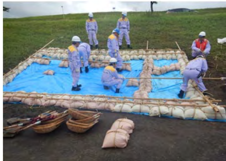
岐阜市水防団 堤防法崩れ対策
