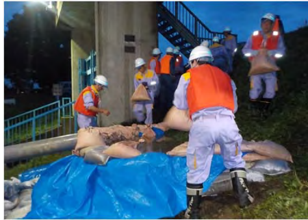
岐阜市水防団 漏水対策
