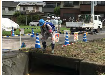
防災エキスパート 被災状況の確認
