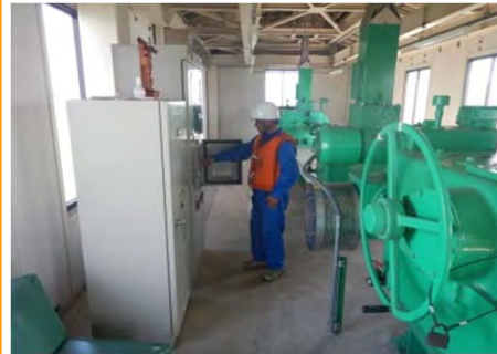
岐阜県 排水樋門の操作
