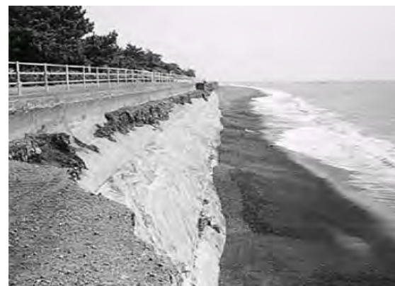
清水海岸の被災状況
