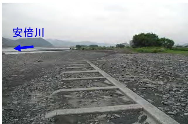
土砂の堆積により河床の高さが上昇している状況 (安倍川左岸6.0km付近)
