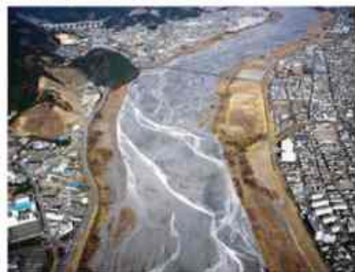
水割れしている状況(平成17年12月)
