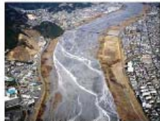
水切れしている状況(平成7年頃)
