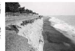
清水海岸の被災状況
