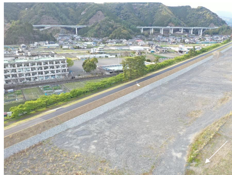
写真: 堤防整備後(右岸12.50km付近) 足久保地区
