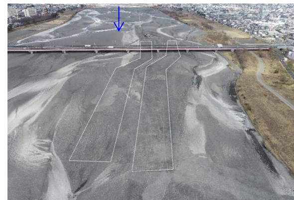
写真: 河道掘削(0.5k付近) 中島地区
