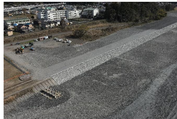
写真: 低水護岸整備(14k付近) 門屋地区
