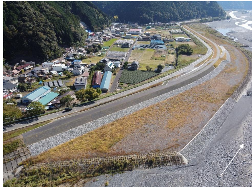
写真:堤防整備後(左岸21.75k付近) 依沢地区
