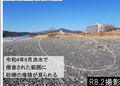
先端部の侵食箇所
