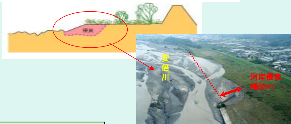
平成12年9月洪水(左岸11.75k付近)
